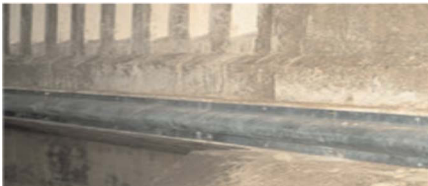
Figura 11 Adosado a un puente
