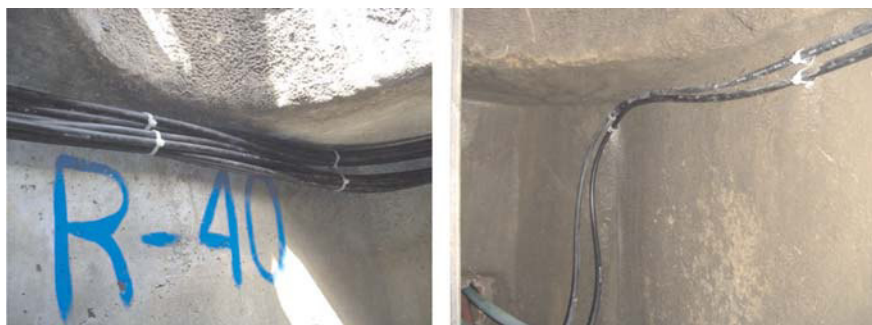
Figura 5 Colocación de los cables en los registros:
