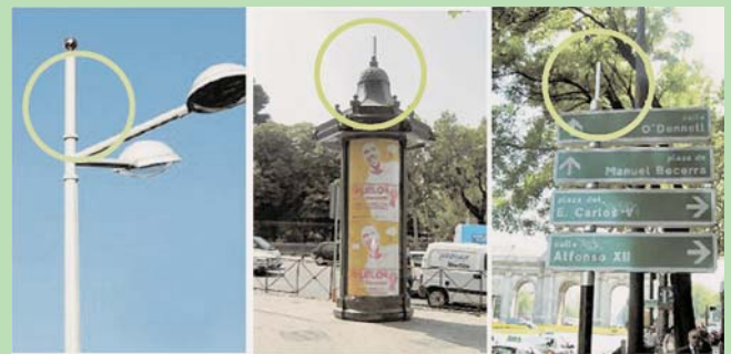
Figura 3 Antenas UMTS camufladas (Fuente: [15]).
